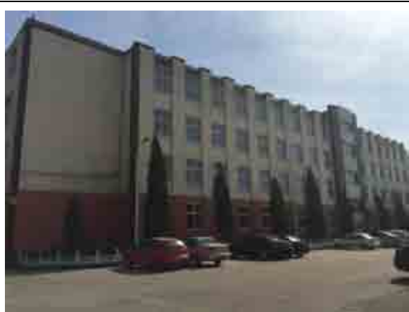
锅炉房西南侧教学楼
