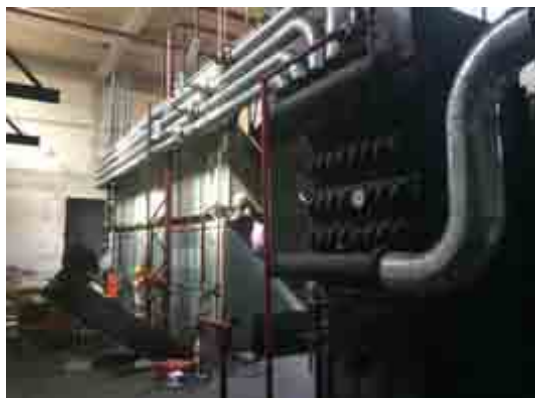
现有工程7.0MW燃煤热水锅炉
