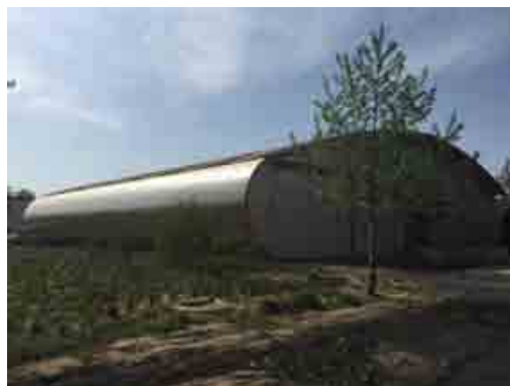
锅炉房西侧实习楼
