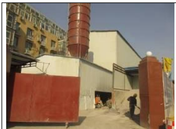
图 4.2-2 施工场地出入口及施工围挡
