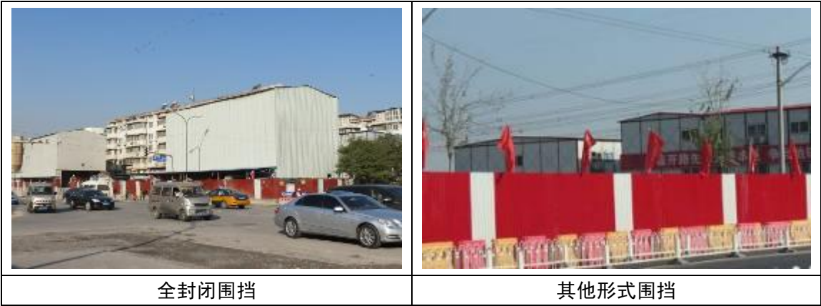
图 4.2-1 施工场地围挡
